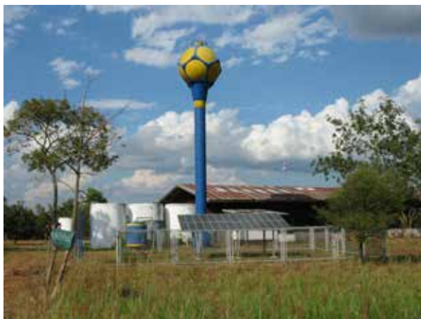
รูปที่ 2.6 การผลิตไฟฟ้าพลังงานแสงอาทิตย์แบบอิสระ สำหรับการประจุแบตเตอรี่แบบรวมศูนย์ ที่อำเภอต๋อยตุง จังหวัดเชียงราย (ด้านบน) และการผลิตไฟฟ้าพลังงานแสงอาทิตย์แบบอิสระสำหรับสูบน้ำเพื่อใช้ในโรงเรียนตำรวจตระเวนชายแดน ที่อำเภอภูพาน จังหวัดสกลนคร (ด้านล่าง) (ที่มา : มจร.)
